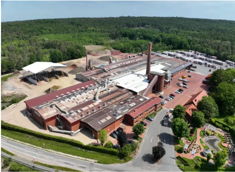
2005 hat Wienerberger das Werk von „Penter Klinker“ in Bramsche übernommen. ARCHIVFOTO: WIENERBERGER ZIEGELINDUSTRIE
